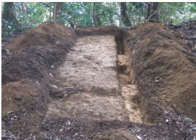
頂上部の平坦地の試掘トレンチ
