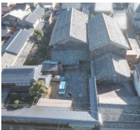
取壊し前の吹野家の2棟の醸造蔵(上空より) 令和5年(2023)1月11日 撮影(有)サンユービルド
